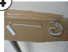
4. 付属のスペーサーをボルトに通してからボルト周りに速乾ボンドを塗ります。
