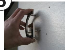
5. ボンドが硬化する前に壁にボルトを差し込んでください。
