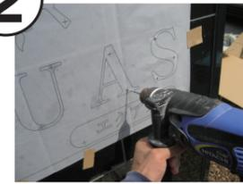
2. 型紙のアンカー位置をめがけて振動ドリルなどで穴を開けます。
