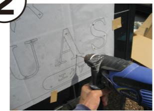
2. 型紙のアンカー位置をめがけて振動ドリルなどで穴を開けます。
