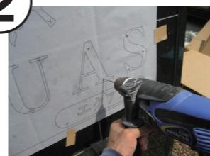
2.型紙のアンカー位置をめがけて振動ドリルなどで穴を空けます。
