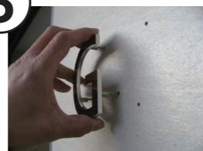
5.ボンドが硬化する前に壁にボルトを差し込んでください。
